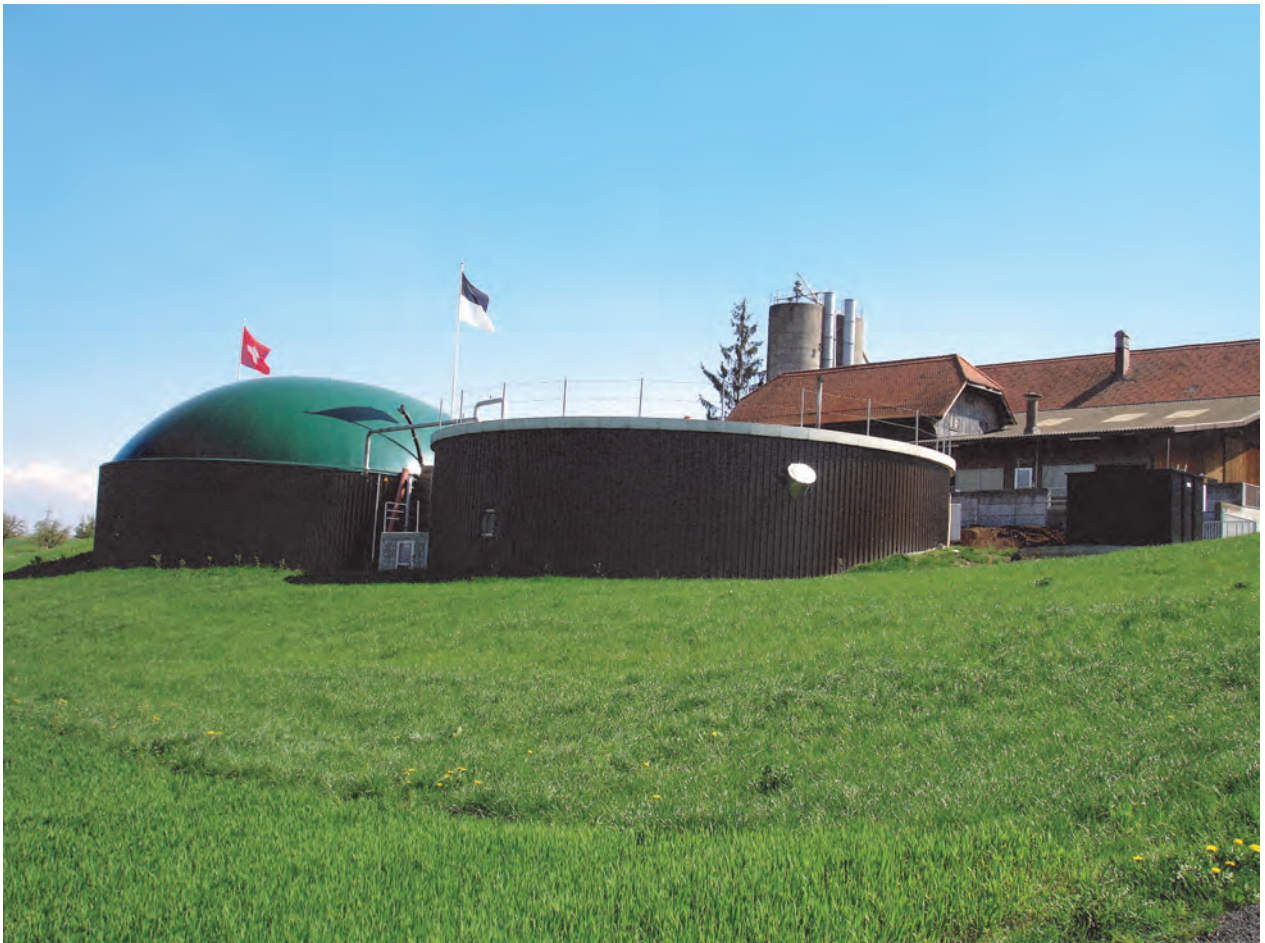
L'installation au biogaz de la famille Schnyder à Bösingen (FR) est un projet pionnier d'utilisation de la biomasse.
