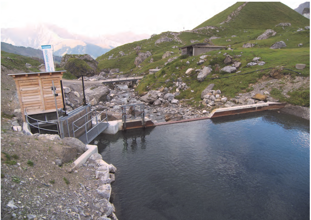
Seuls les murs de retenue de l'ancienne centrale électrique de 1934 sont encore debout. Un dispositif de calcul automatique et un dessableur y ont été ajoutés.
