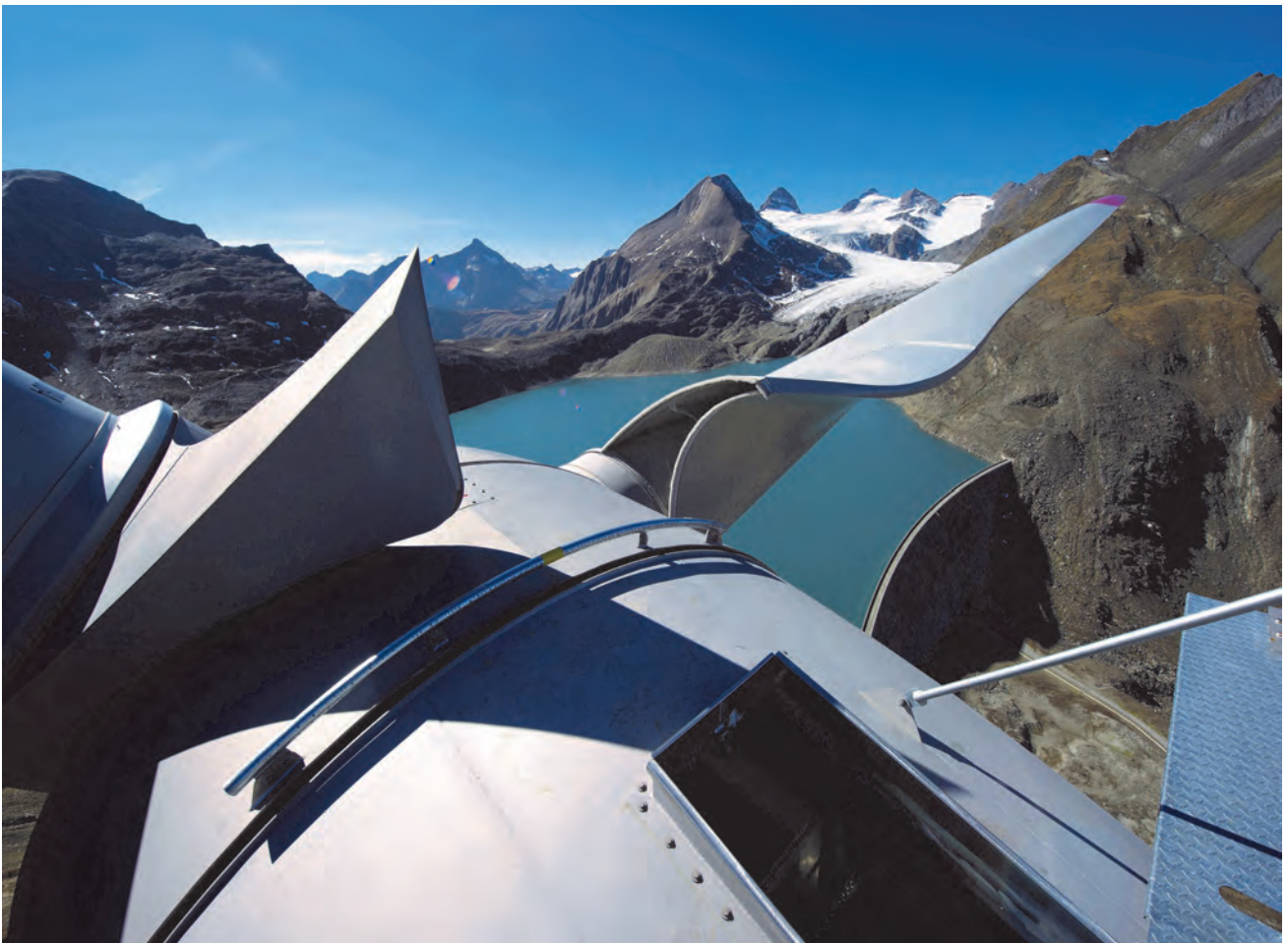
L'installation éolienne du Gries, dans le Valais, est la plus élevée d'Europe.
