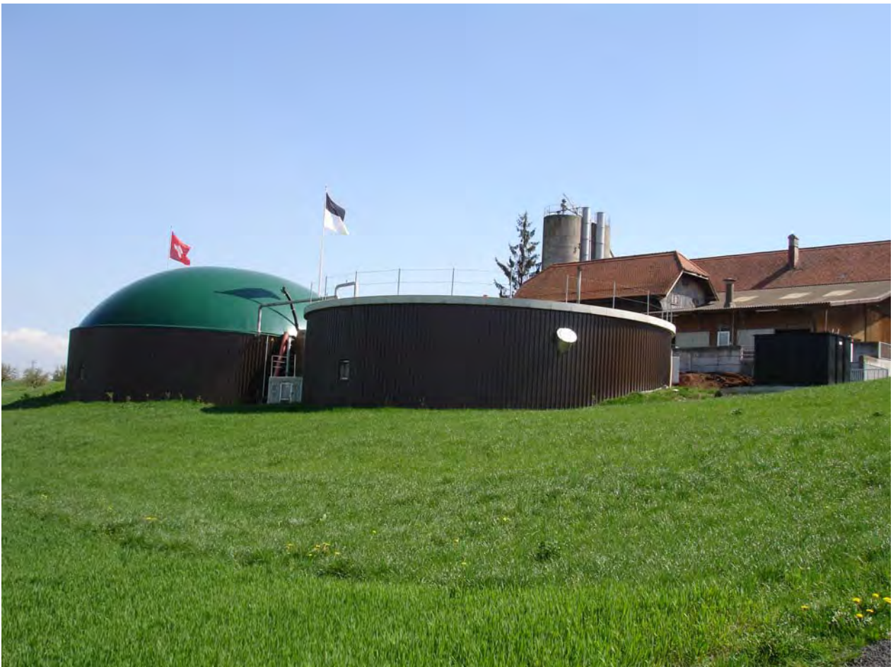
Die Biogas-Anlage der Familie Schnyder in Bösinggen (FR): Pionier der Biomasse.
