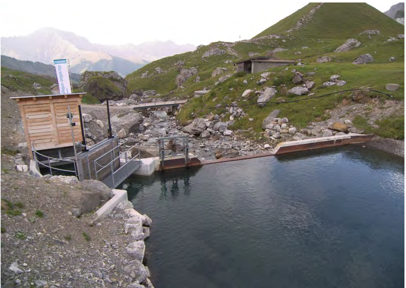
Nur die Wehrmauer stammt noch vom alten Kraftwerk von 1934. Daneben wurden eine automatische Rechenanlage und ein Entsander gebaut.
